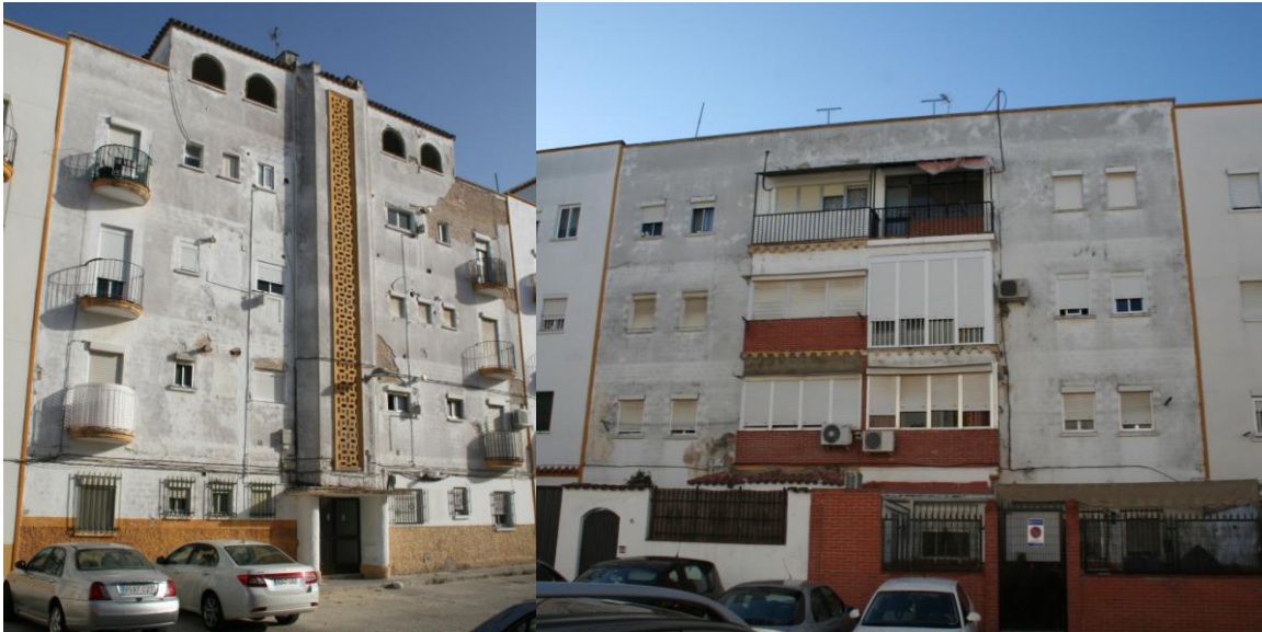
Fig. 2. Estado original de la edificación. Fachada principal y trasera. Pza. Virgen de Loreto nº3. Barriada de La Plata. Jerez de la Frontera.
