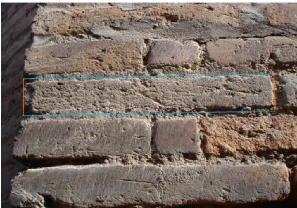
Fotografía 27: Vista de los muros de albañilería de ladrillo y argamasa de cal en la Basílica del Salvador. Ed. Autor.
