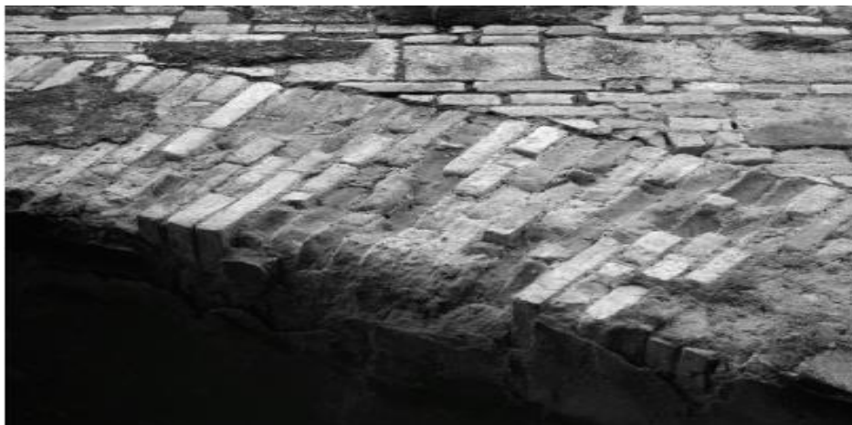
Fotografía 28: Albañilería de ladrillo y argamasa de cal analizada sobre el puente Popayan del río Cauca, Colombia. Se realizan ensayos de caracterización para estudiar propiedades mecánicas 68 .
