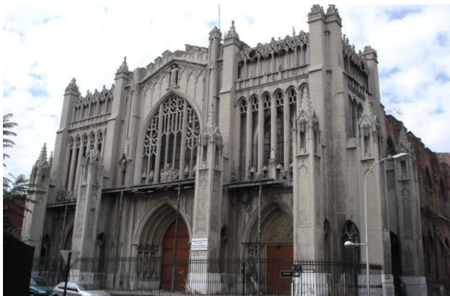
Fotografía.1: Vista de la fachada Norte de la Basílica del Salvador 1 .
