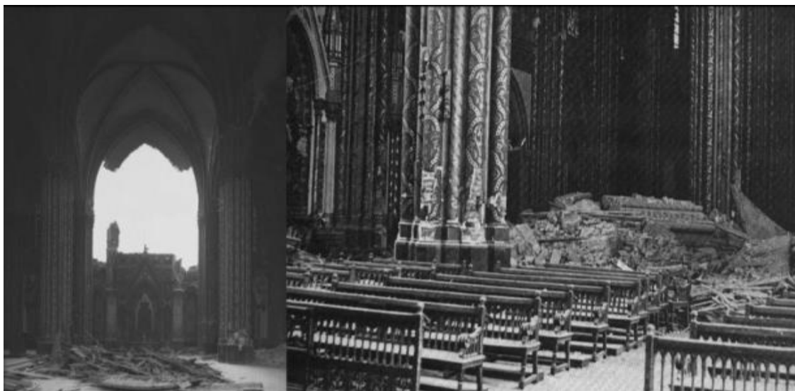
Fotografía.3: Daños en el interior de la Basílica del Salvador tras el terremoto de 1985, vista del transepto y la nave central 7 .
