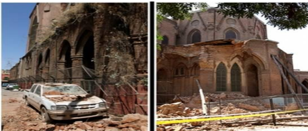
Fotografía 9: La Basílica del Salvador, vista lateral y fachada sur. Después del sismo del año 2010 40 .
