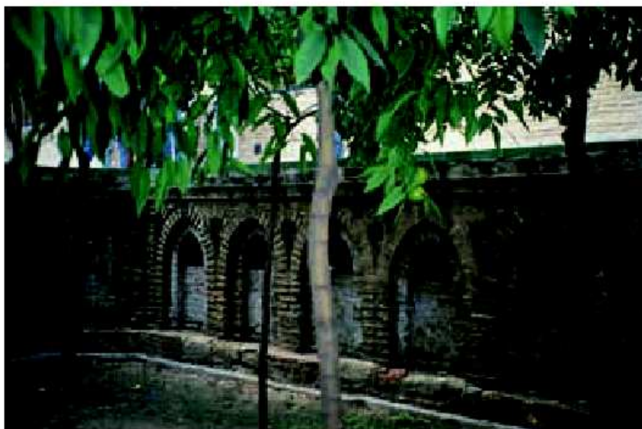
Foto 3.- Sevilla Jardín Rehundido. Nivel Bajo. Arcos de ladrillos resaltados.
