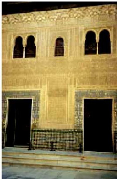
Foto 4.- Puerta de Comares. Actualmente en el Patio del Cuarto Dorado. La Alhambra (foto autora).
