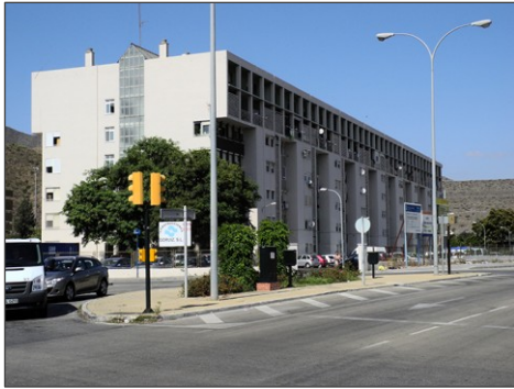
Figura 51. Imagen exterior del edificio bajo reforma
