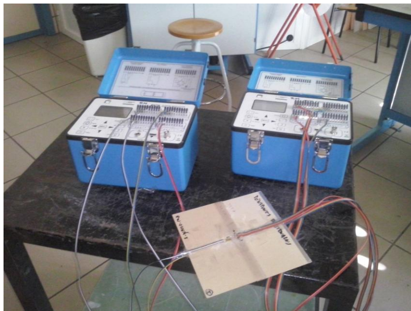
Figura 33 Conexión de los equipos e instrumentación del panel
