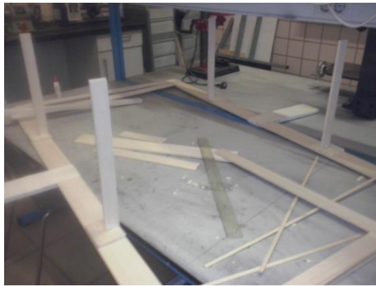
Figura 6.9. Soportes verticales colocados en la estructura principal
