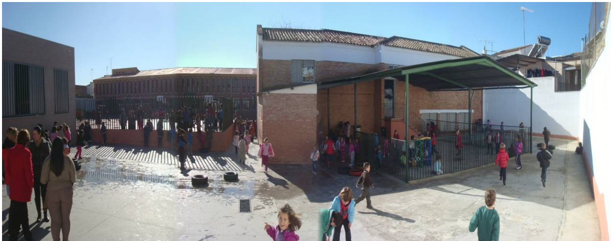
Fig.8 "Sustitución de edificio de aulas de infantil, en colegio público entre medianeras. Estado inicial. Arq.: estudio republica_dm"
