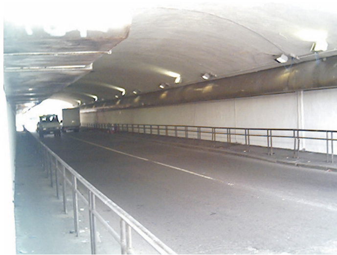
Fig. 5 “Túnel Via Porpora, Milán”
