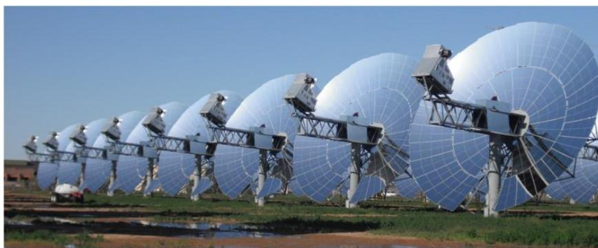
Figura 6. Disco Parabólico Stirling [temposenergia.es]
