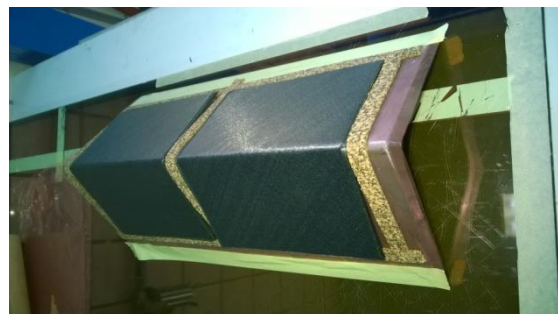
Figura 3-5. Laminación de los paneles de las ILTS (2)
