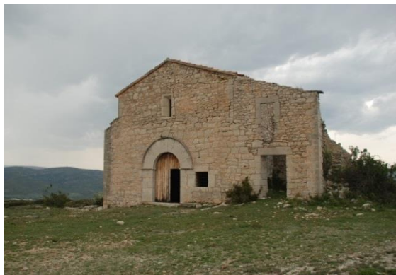
Figura 1. Vista general de la Ermita de San Vicente en Catí.
