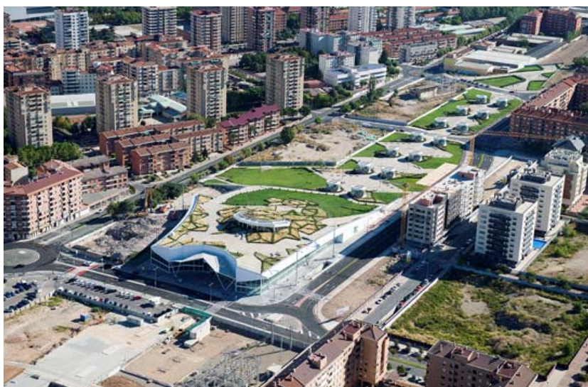
Figura 9. Fotografía aérea del punto de partida para el proyecto de Autobuses (obra de la Fase I ferroviaria)
