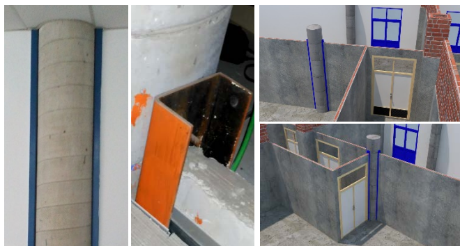
Fig. 77: Fotografías reales y animaciones de uniones entre particiones y pilares de HA en Planta Baja. Las dos primeras imágenes son fotografías reales realizadas en la inspección nº 2 y las otras dos son animaciones extraídas del modelo, Allplan. (Elaboración propia).
