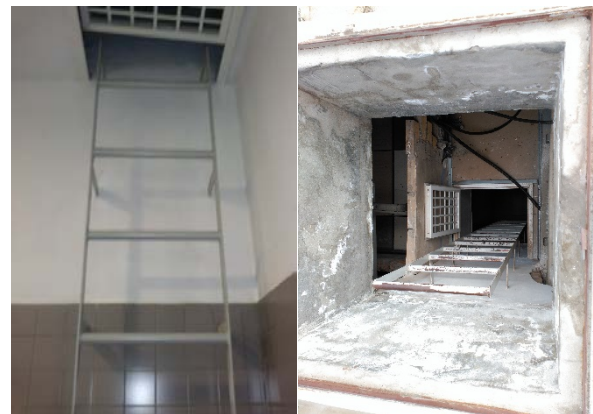
Fig. 33: Fotografías de la trampilla de acceso a la cubierta. En las imágenes puede observarse una vista desde Planta Primera, a la izquierda, y otra desde la cubierta, a la derecha. (Elaboración propia).
