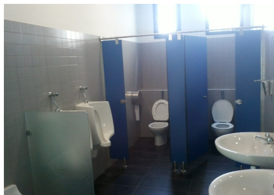
Fig. 86: Fotografía de aseos de Planta Primera. En estas se observa tanto el acabado de superficies laterales como la solería de los mismos. (Elaboración propia).
