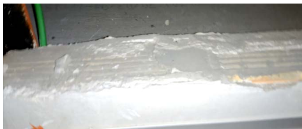
Fig. 75: Fotografía de partición tipo de Planta Baja. Extraída en la Inspección nº 2. (Elaboración propia).
