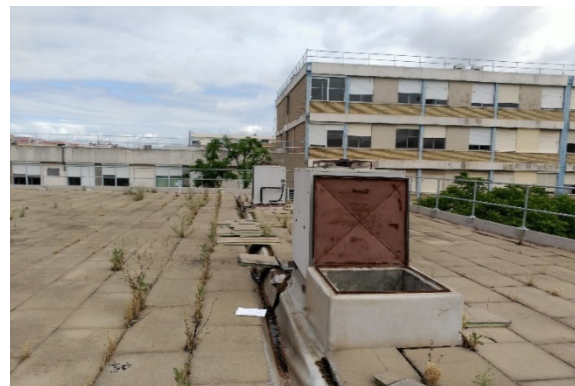
Fig. 39: Fotografía de Cubierta. Puede observarse la trampilla de acceso a cubierta, el canalón central de desagüe, el pretil perimetral y la barandilla, así como la solería de acabado de cubierta. (Elaboración propia).
