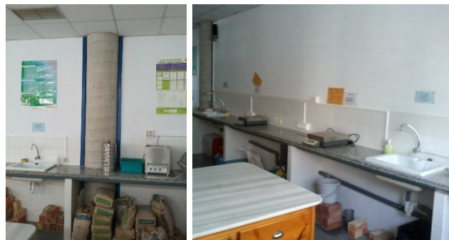
Fig. 84: Fotografías de acabados de superficies laterales en locales húmedos de Planta Baja. En las mismas se observan los acabados superficiales laterales existentes en Laboratorio 01 y Laboratorio 02, respectivamente. (Elaboración propia).
