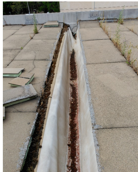
Fig. 72: Fotografía de canalón de desagüe de cubierta. (Elaboración propia).
