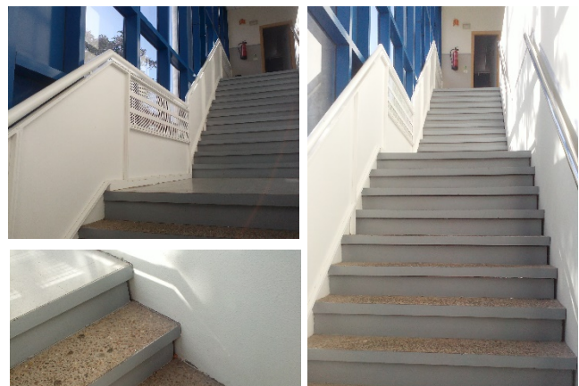
Fig. 82: Fotografías de acabados de la escalera del edificio. En las presentes puede observarse el acabado superficial de los bloques que conforman los peldaños, la composición de los mismos y la barandilla y pasamanos que presenta la misma. (Elaboración propia).
