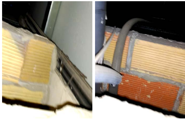
Fig. 25: Fotografías obtenidas en la Inspección nº 3. En las imágenes se puede observar el falso pilar para paso de instalaciones del que se habla en el presente apartado. (Elaboración propia).
