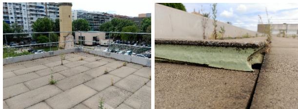
Fig. 73: Fotografías de elementos de fachada. En estas se puede observar por una parte la composición de la barandilla de seguridad y el pretil perimetral, en la imagen izquierda, y por otra parte la solería de cubierta, en la imagen derecha. (Elaboración propia).
