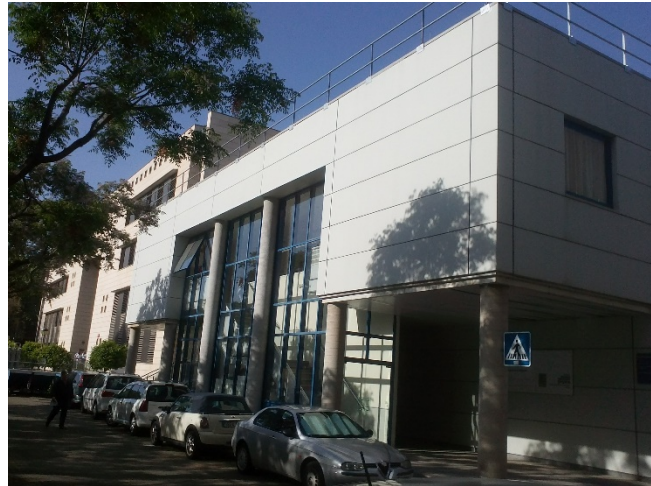
Fig. 10: Edificio de Laboratorios de la E.T.S.I.E. Fotografía de fachada principal de acceso al edificio. (Elaboración propia).
