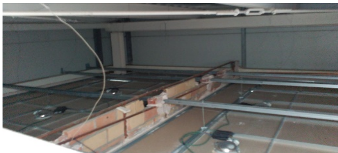
Fig. 79: Fotografía de partición en aseos de Planta Primera, extraída en la inspección nº 9, a través de la trampilla de acceso a la cubierta. (Elaboración propia).
