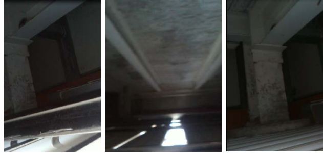
Fig. 31: Instantáneas obtenidas a partir de los videos generados en la Inspección nº 8. En estas se observa la unión de la perfilería de fachada a la estructura, la disposición o dirección de carga de las viguetas y la unión entre viga y pilar, describiéndolas de izquierda a derecha. (Elaboración propia).
