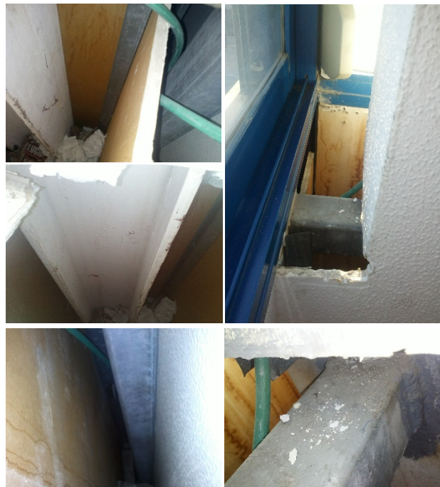
Fig. 37: Conjunto de fotografías obtenidas en la Inspección nº 11. En estas se observan los elementos analizados en dicha inspección: Pilar HEB 200, recubrimiento de pilar, perfiles auxiliares del cerramiento de fachada, unión de perfiles al pilar. (Elaboración propia).
