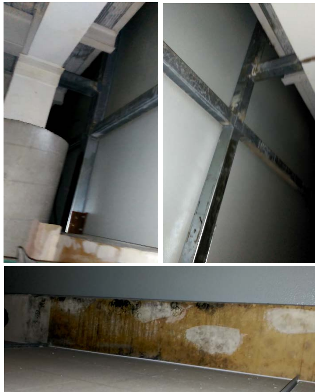
Fig. 26: Montaje realizado a partir de las fotografías obtenidas de la inspección nº 4. En estas se observan los elementos que se han analizado en dicha inspección. (Elaboración propia).
