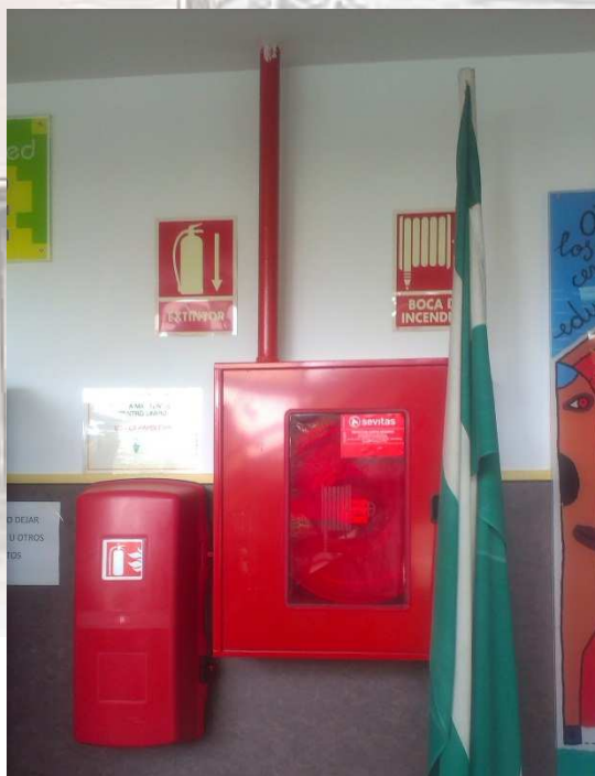
Imagen 52: BIE en hall Principal, Planta Baja. Fuente: Fotografía de la autora
