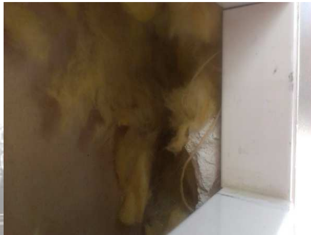
Imagen 11 : Interior de cerramiento tipo Panel Sandwich. Fuente: Fotografía de la autora
