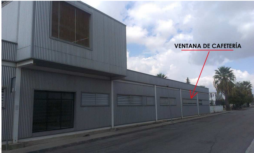
Imagen 63: Fachada noroeste, ventanas. Fuente: Fotografía de la autora
