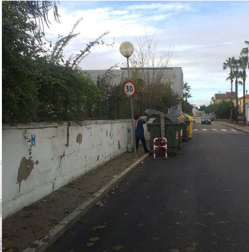
Imagen 24 : Situación de vertederos de basura en fachada noroeste. Fuente: fotografía de la autora
