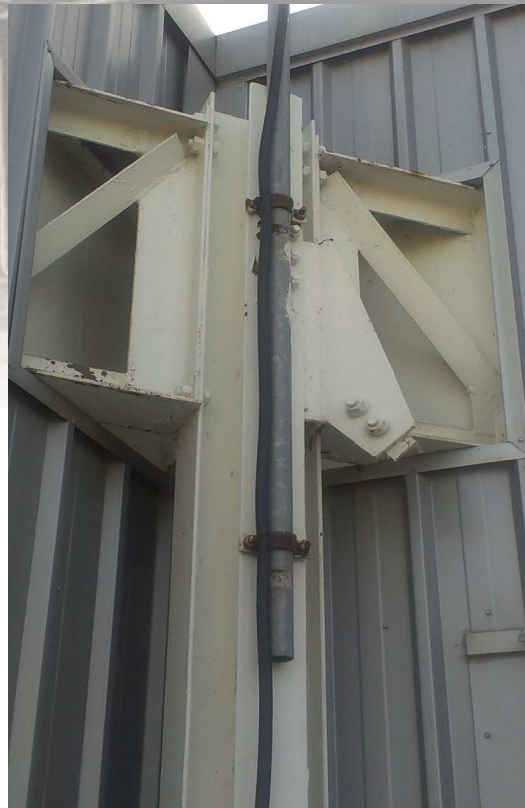
Imagen 10: Unión Vigas Pratt con pilares metálicos. Fuente: Fotografía de la autora
