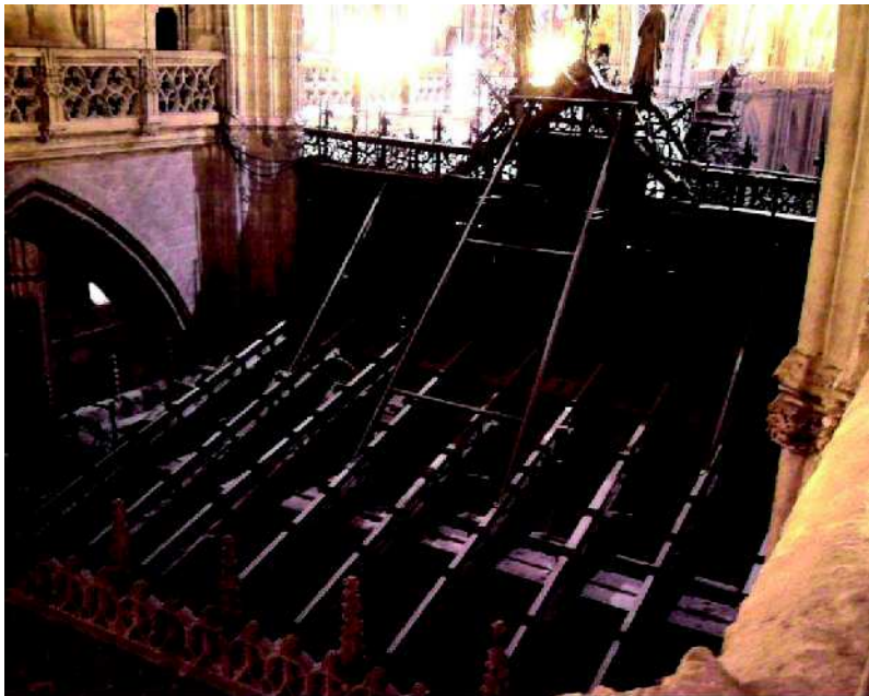
Fig. 4 - Estructura del apeo del dosel del retablo de la catedral de Sevilla.
