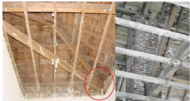
Fig.21. A la izquierda encontramos uno de los empotramientos de las cabezas de las vigas; a la derecha se aprecian los apoyos de una de las cerchas principales en el pilar de fábrica de ladrillo dispuesto para tal fin. Ayuntamiento de El Pedroso y realización propia.
