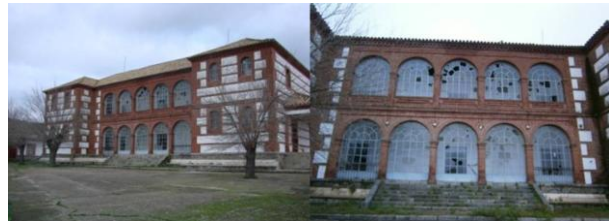
Fig.31. Fachada posterior, por la que también se puede acceder al interior del edificio, a través de las escaleras. (Elaboración propia).
