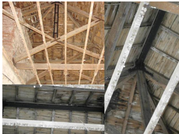
Fig.26. Refuerzos de acero en vigas de cumbrera y en el pendolón de una de las cerchas principales. (Elaboración propia).
