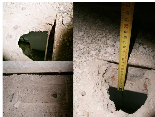
Fig.19. Fotografías tomadas durante una de las visitas al edificio. Cata realizada en el forjado de planta primera. Realización propia.
