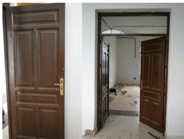
Fig.33. Carpinterías de madera interiores. (Elaboración propia).
