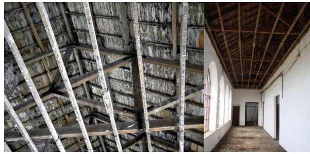
Fig.20. Cercha principal; en la izquierda aparece la parte de la cercha ubicada encima de las aulas y en la derecha se observa su continuación hasta la fachada posterior. (Ayuntamiento de El Pedroso y elaboración propia).
