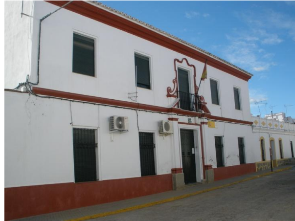
Fig.12. Estado actual de la casa cuartel, hoy día solo se encuentra habitable la nave principal, cuya fachada se encuentra en la calle Ramón de Carranza. (Elaboración propia).
