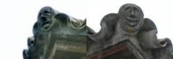
Fig.17. Algunas de las caras talladas en hormigón que rematan las limatesas de las diferentes cubiertas. (Elaboración propia).
