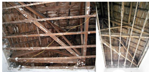
Fig.23. Ambas fotografías pertenecen a la esquina noreste del edificio. (Elaboración propia).
