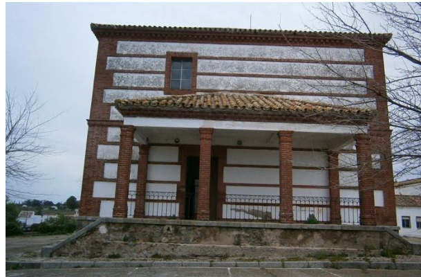
Fig.15. Vista de la fachada sur, donde se encuentra uno de los porches. Se observa el desnivel del terreno y los muros de mampostería de piedra sobre los que apoya el forjado de planta baja. (Elaboración propia).
