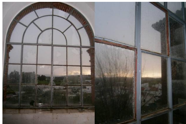
Fig.32. Carpintería metálica correspondiente a una de las ventanas de la fachada posterior de planta primera. (Elaboración propia).
