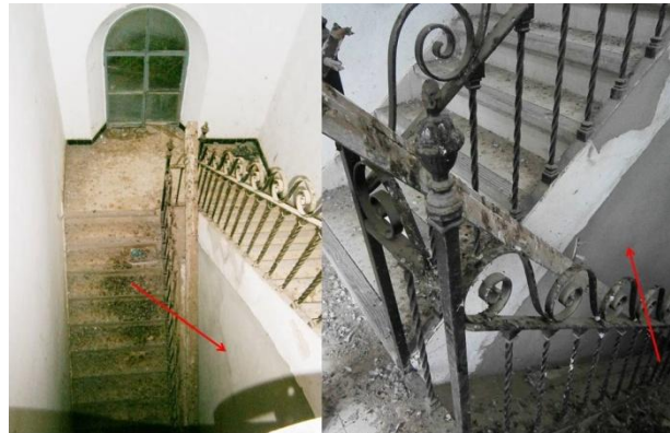
Fig.14. En estas imágenes se aprecia la incorporación del nuevo tabique bajo la zanca original de la escalera. (Elaboración propia).
