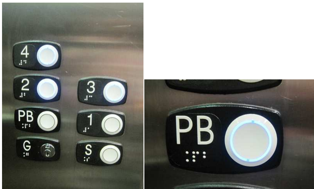
Detalle de botonera de ascensor con números en altorrelieve y braille, y de botón con señalización luminosa al ser pulsado. © Anabel Carpio
