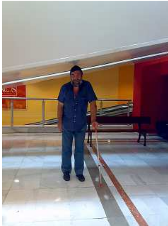
Espacio bajo al rampa inferior a 220 centímetros. Da lugar a tropiezos. © Anabel Carpio
