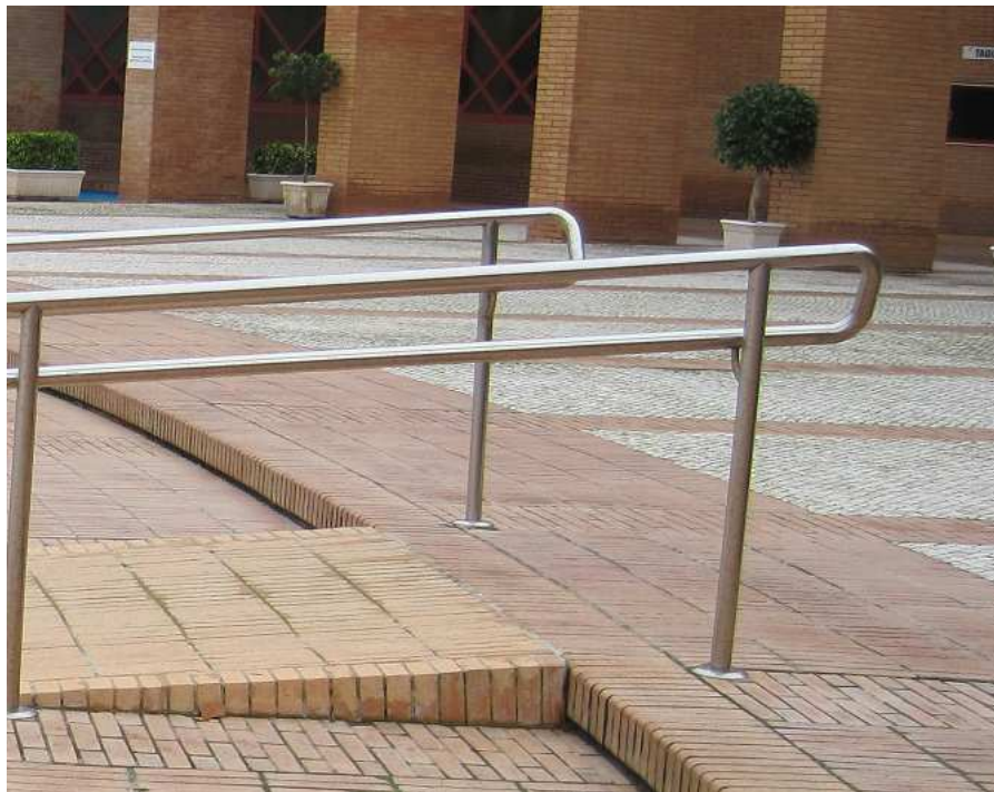
Remate de los pasamanos en rampa. Se prolonga 30 centímetros y se une el pasamano superior con el inferior formando curva. © Anabel Carpio
