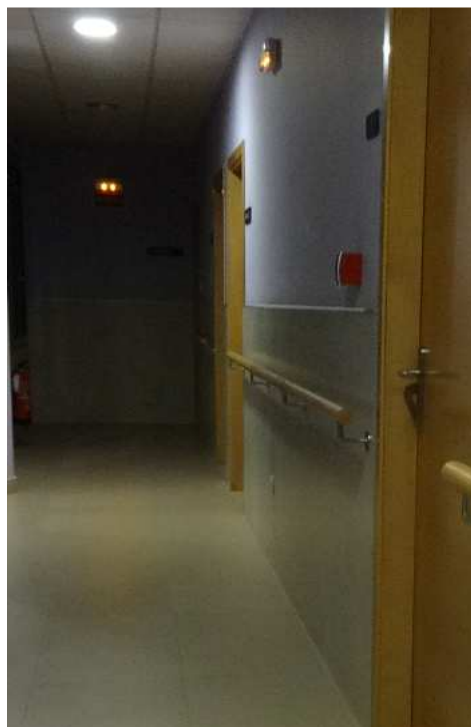
Pulsador situado entre 0,80 y 1,20 m de altura. © Anabel Carpio
