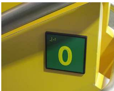
Señalización en altorrelieve y en braille como información de planta de escaleras. © Anabel Carpio
