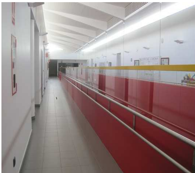
Pasillo con pasamanos. Se observa también que los extintores y mangueras están embutidos en el paramento y las puertas están retranqueadas. © Anabel Carpio
