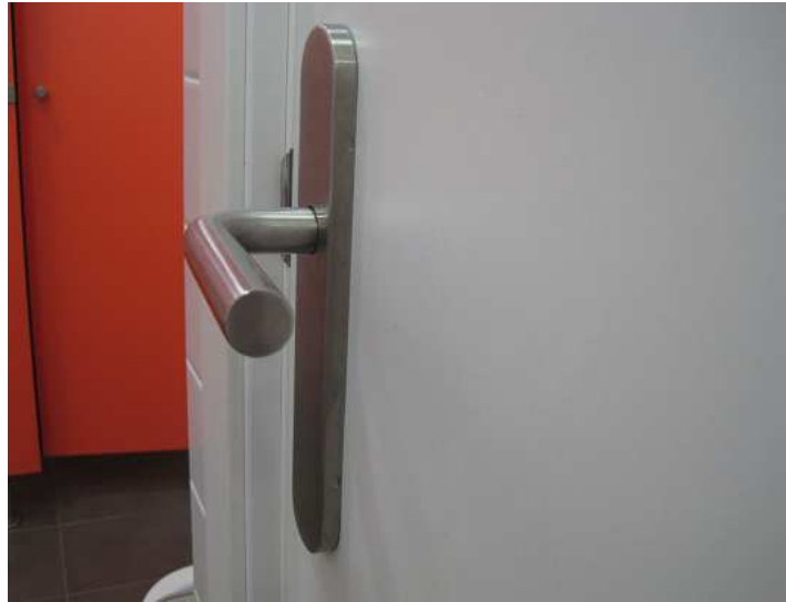
Maneta accionable por una sola mano, buen contraste cromático y separación entre esta y la hoja. © Anabel Carpio
