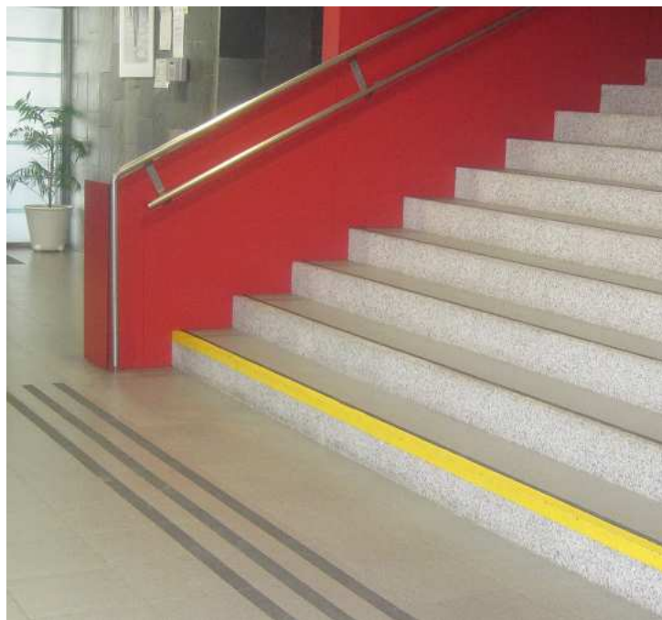
Detalle de doble pasamanos en escaleras. © Anabel Carpio
