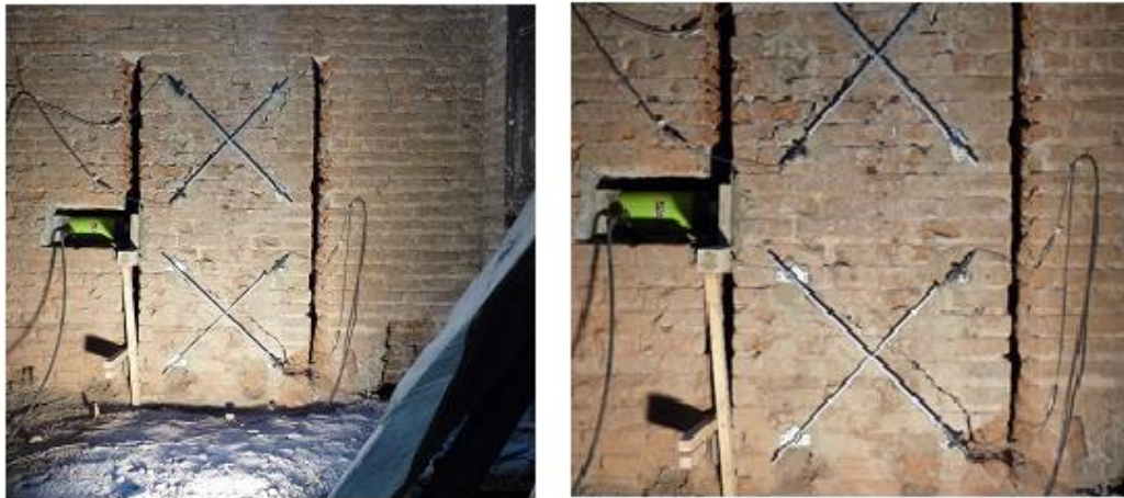
Figura 6: Ensayo de corte in-situ al interior de la estructura
