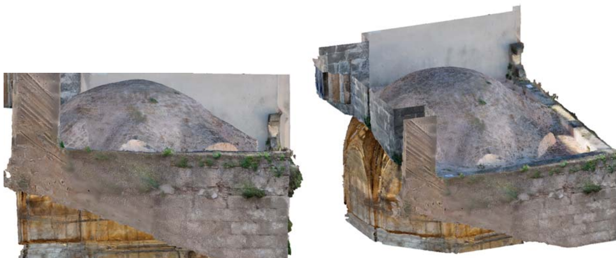
Figura 6. Levantamiento fotogramétrico del trasdós de la bóveda. Con un total de 5E6 caras y con un error del orden de 2 píxeles.
