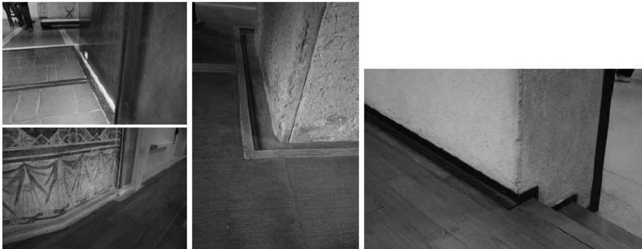
*Detalles de los zócalos: diferentes soluciones formales y materiales para resolver el encuentro entre las superficies horizontales y los paramentos (46)*
