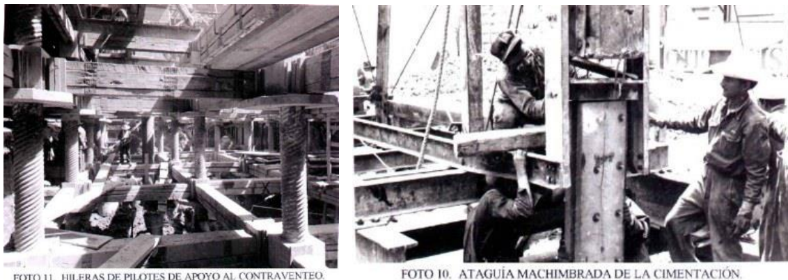
FOTO 11. HILERAS DE PILOTES DE APOYO AL CONTRAVIENTO.
