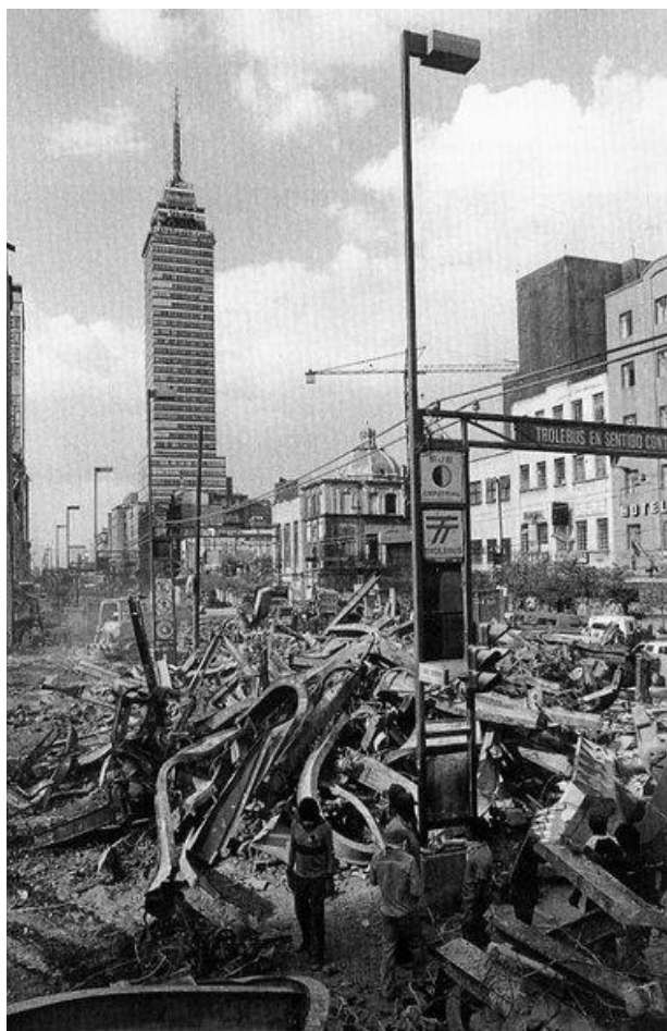
Figura 13. Estado de la torre tras el terremoto
