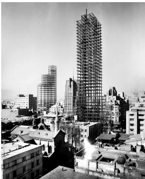
Figura 11. Construcción de la Torre Latinoamericana
