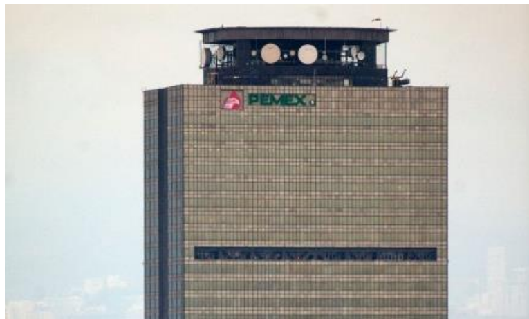
Figura 16. Vista del helipuerto.
