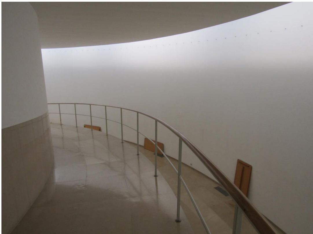
Museo. Iluminación cenital de forma mixta: natural y artificial. Rampa semicircular de acceso a la biblioteca.
