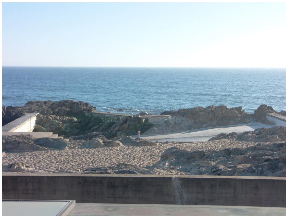
Vista de las dos piscinas desde el paseo marítimo antes de ser llenadas, en temporada de invierno.
