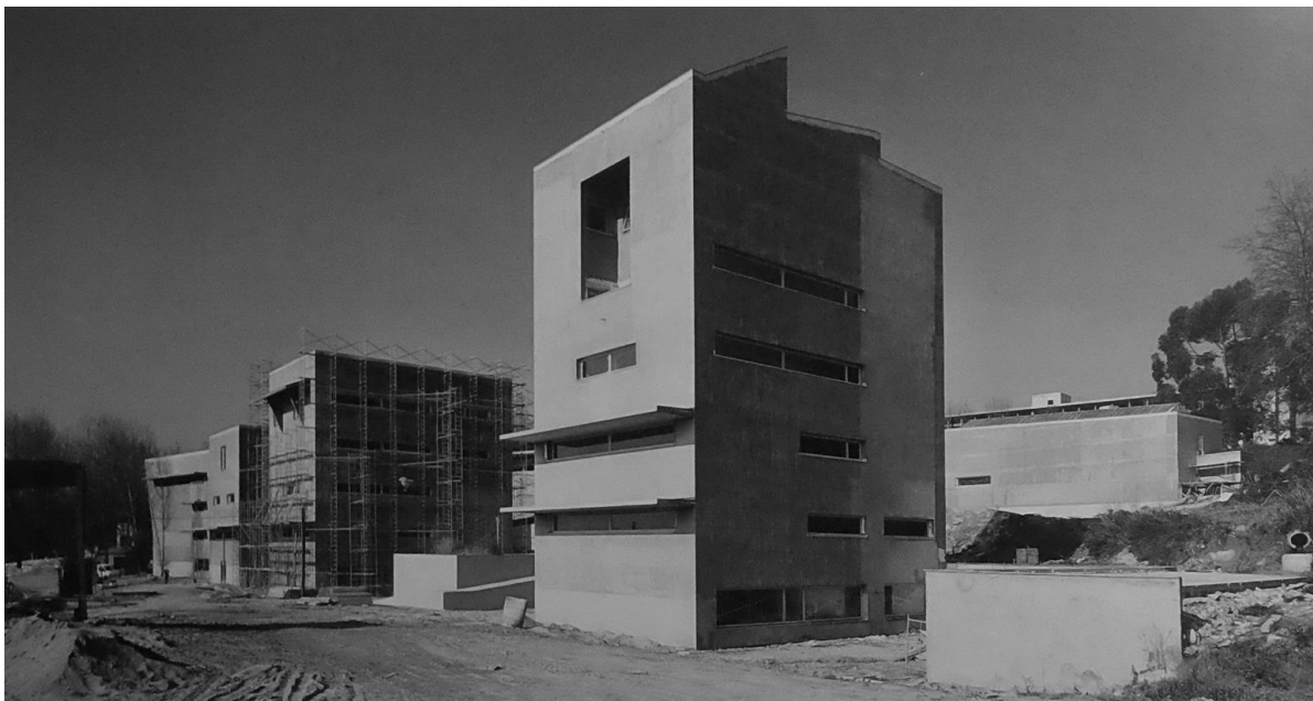
Construcción de la FAUP: desencofrado de las torres aulario tras el hormigonado.
