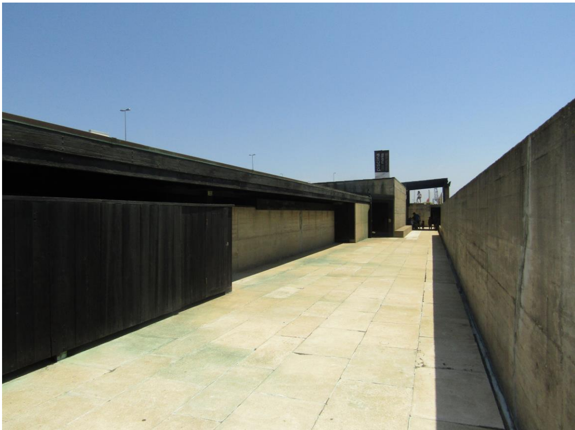
Corredor que sale de los vestuarios y llega a la salida hacia los aseos y las piscinas.
