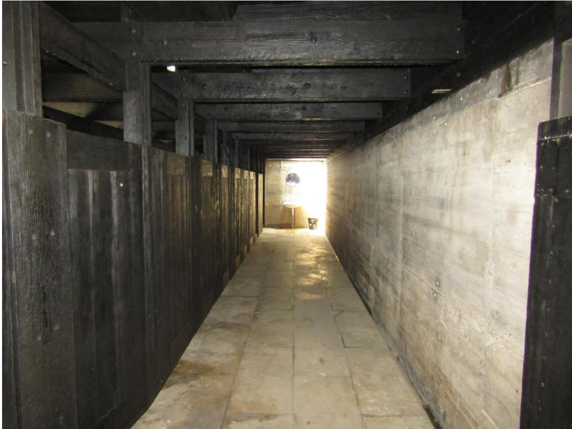
Vestuario. La iluminación se hace a través del lucernario sobre el lavabo al final del pasillo.
