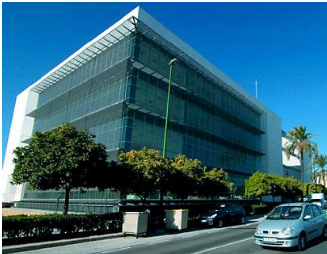
Figura 27: Vista exterior Jefatura de la Policía Local de Sevilla. Fuente: El Correo de Andalucía, 05-03-2015.
