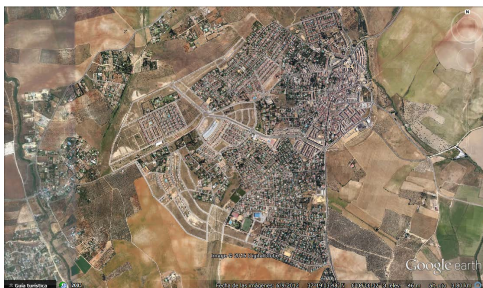
Fig. 24. Vista aérea de Las Haciendas (Palomares del Río) una vez iniciadas las obras, encontrándose actualmente en proceso de paralización (2012). Fuente: Google Earth.
