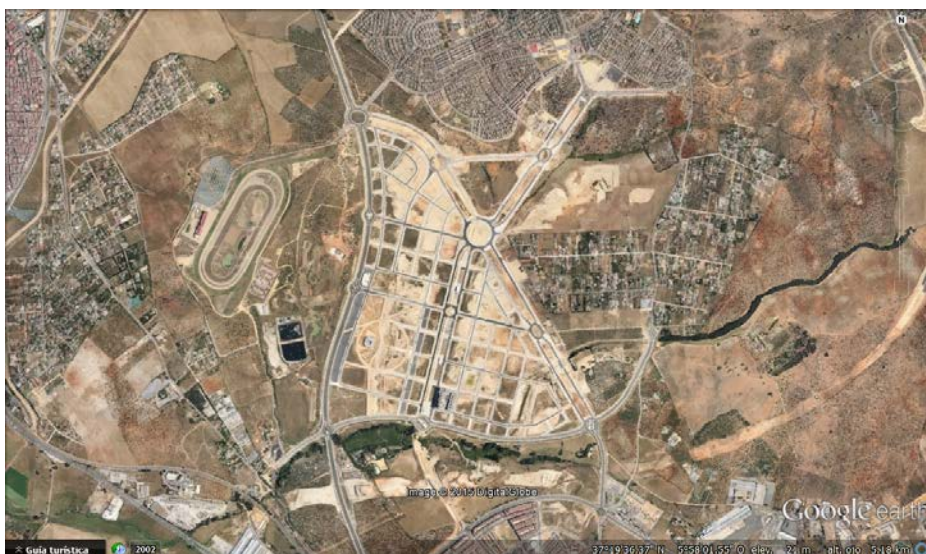
Fig. 22. Vista aérea de Entrenucleos (Dos Hermanas) una vez iniciadas las obras, encontrándose actualmente en proceso de paralización (2015). Fuente: Google Earth.
