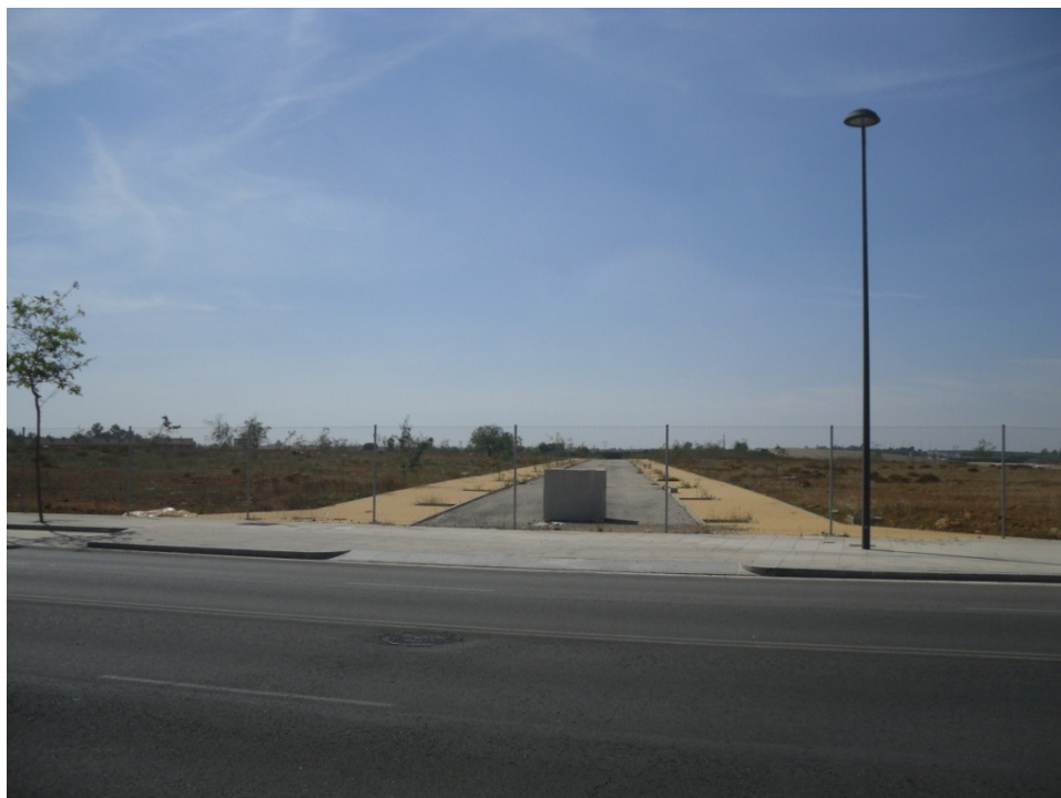
Imagen 2. C/La Habana. Campo de las Beatas. Emplazamiento de la actualmente paralizada nueva urbanización. En el interior las manzanas y servicios urbanos están realizados y se ha realizado la división de las parcelas. Todo el entorno está vallado. Foto: realización propia.
