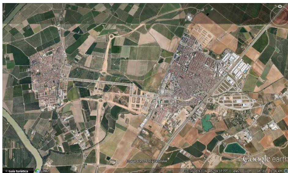
Fig. 28. Vista aérea de Pago de En medio (La Rinconada) una vez iniciadas las obras, encontrándose actualmente en proceso de paralización (2015). Fuente: Google Earth.
