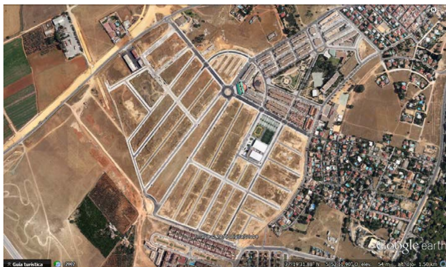
Fig. 32. Vista aérea de Campo de las Beatas (Alcalá de Guadaíra) una vez iniciadas las obras, actualmente en proceso de paralización (2015). Fuente: Google Earth.
