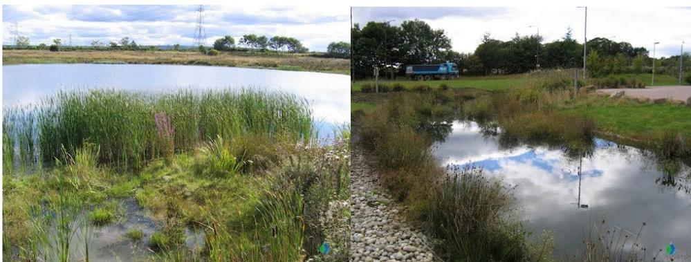
Figura 27: Ejemplo de estanques de retención. Fuente: Ana Abellán
