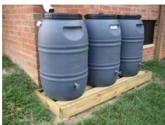
Figura 25: Ejemplo de depósito de lluvia. Fuente: Ana Abellán
