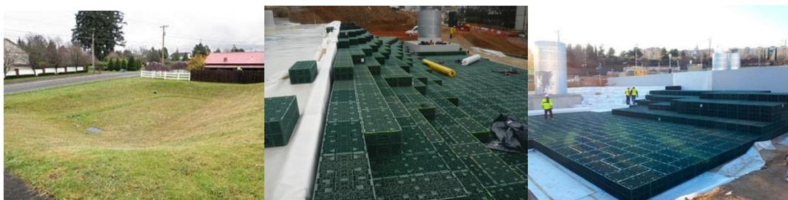
Figura 20: Ejemplos de depósitos de infiltración. Fuente: Ana Abellán.
