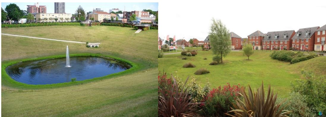
Figura 26: Ejemplo de depósitos de detención superficiales. Fuente: Ana Abellán
