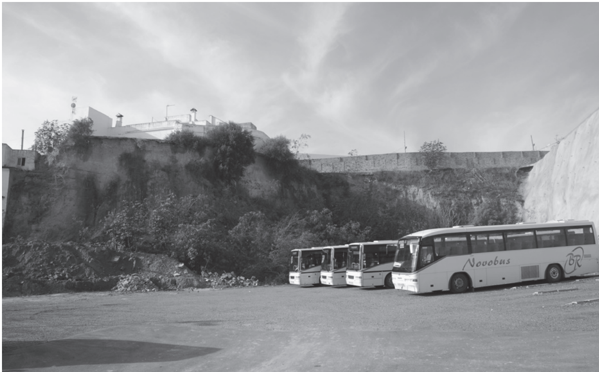
Lámina II. Vista parcial del Cerro del Castillo donde se observa la extracción de tierra realizada hace unos años y los desplomes que sufre actualmente
