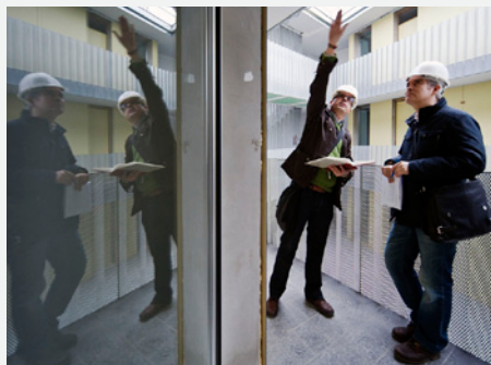
Dirección de obra de viviendas en el casco histórico de Sevilla foto Pedro María de Ugarte
