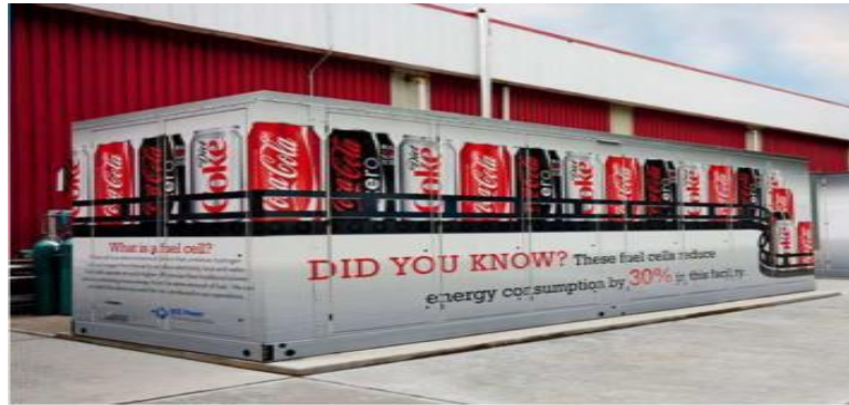
Figura 14. Ejemplo de aplicaciones estacionarias basadas en pilas de combustible tipo PEM
