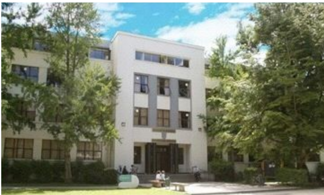
145 y 146- Plano general de la Universidad de Concepción y fotografía del edificio de Química y Farmacia.
