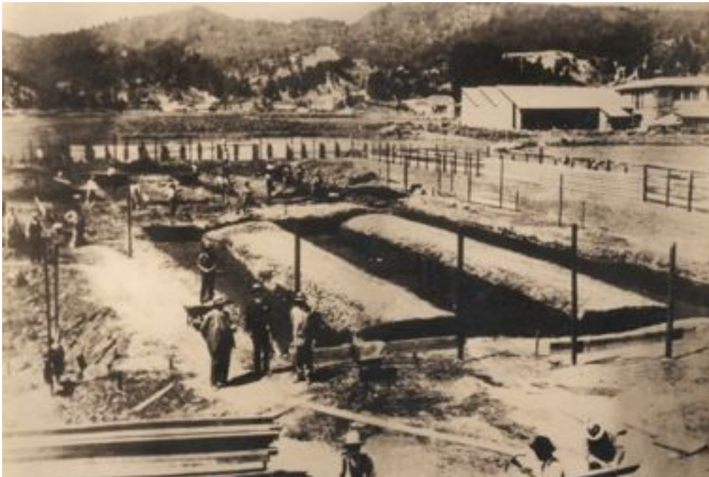
26. Primeros trabajos en el sitio la Toma
