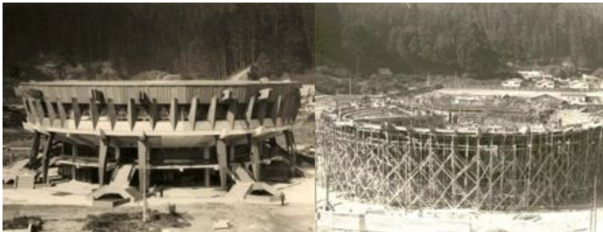
95 y 96. Construcción del Edificio de Aulas Salvador Gálvez llamado “El Plato”
