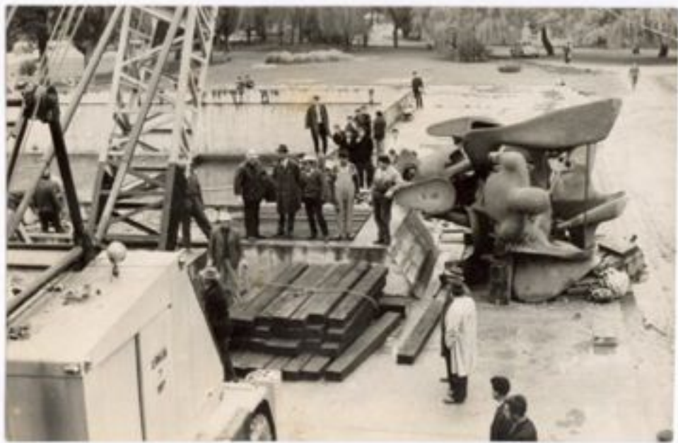
86- Instalación Monumento a los Fundadores
