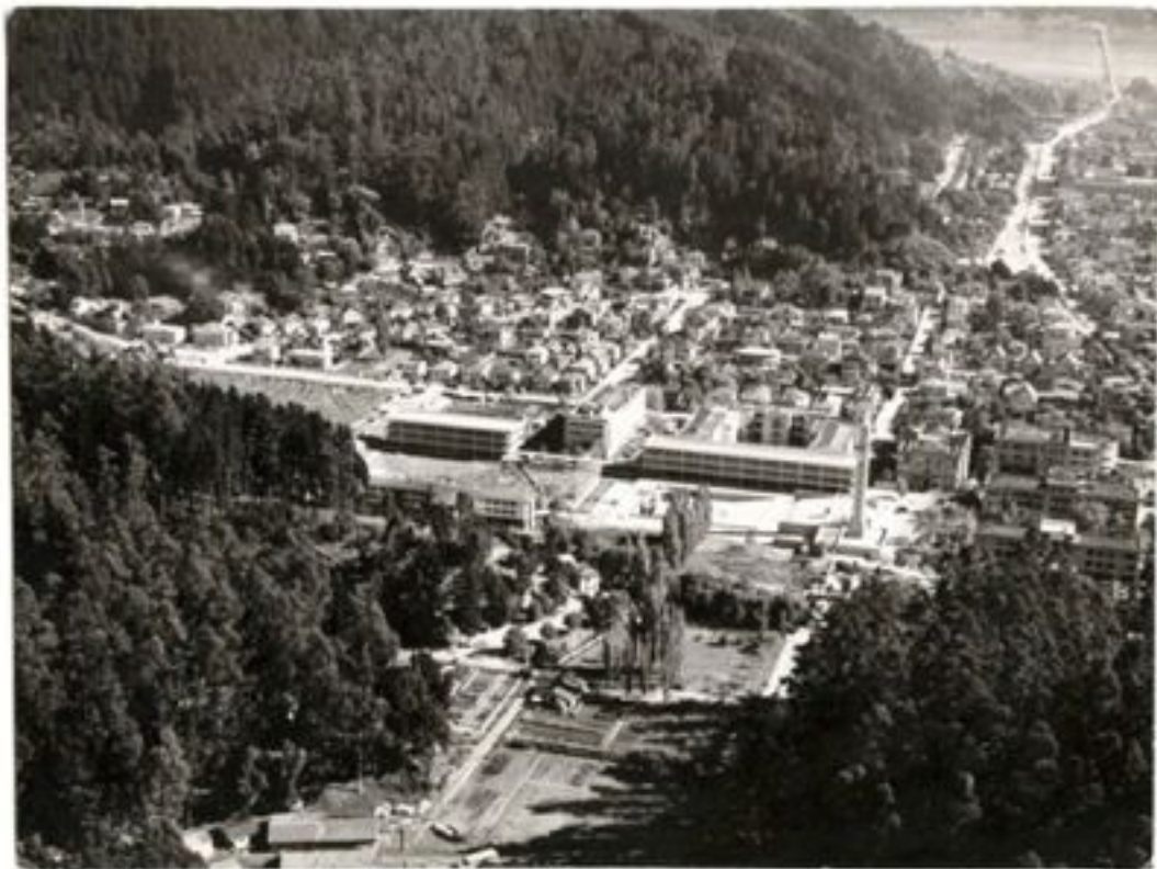
18. En la fotografía apreciamos al fondo el antiguo puente conexión con la Araucanía continua por la Alameda actual calle Víctor lamas hasta la ciudad Universitaria por el borde del Cerro Caracol.
