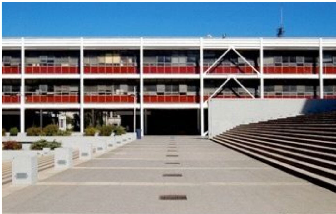
149 y 150- Plano general de la Universidad de Concepción y fotografía de edificio metálico Instituto de Química.
