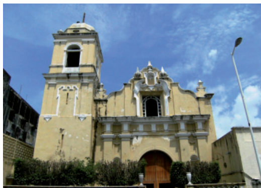
Fig. 5. Capilla de la Pastora. C. 1746-54. Veracruz. Detalle de la fachada principal.
