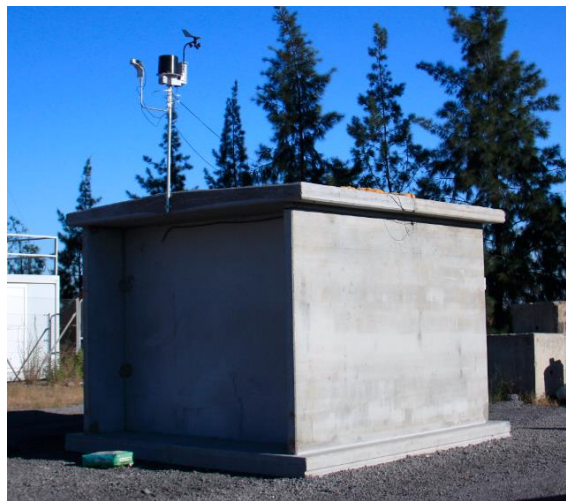
Figura 4-4. Vista de la caseta en la que se aprecia la posición de la estación meteorológica
