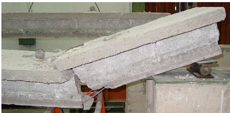
Imagen IV.3.4.-a Rotura por flexión en forjado P03a (T-11-3). All-pg.642
