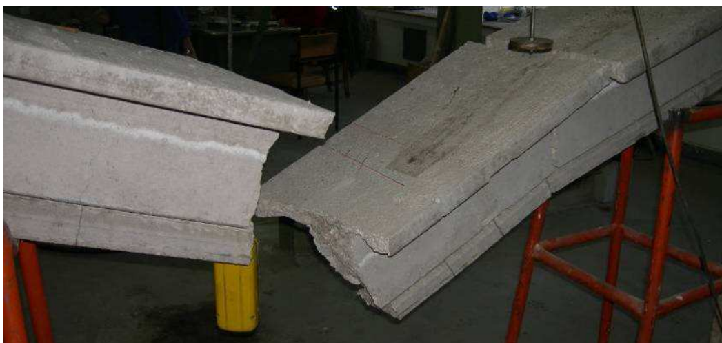
Imagen IV.3.5.-a Rotura por flexión en forjado C04bis (T-11-2). All-pg.6604
