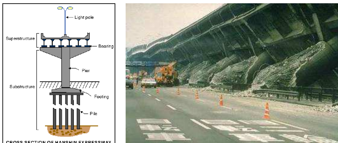
Fig. 1.2.-c. Colapso en las pilas del Hanshin Expressway (Japón 1995)
