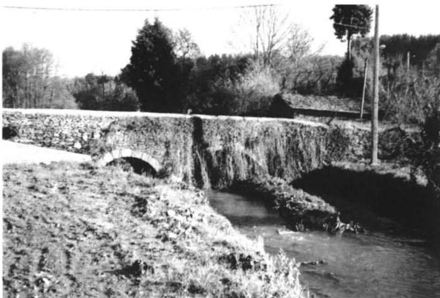
FIG. 1. Puente de la Chanca (Lugo)
