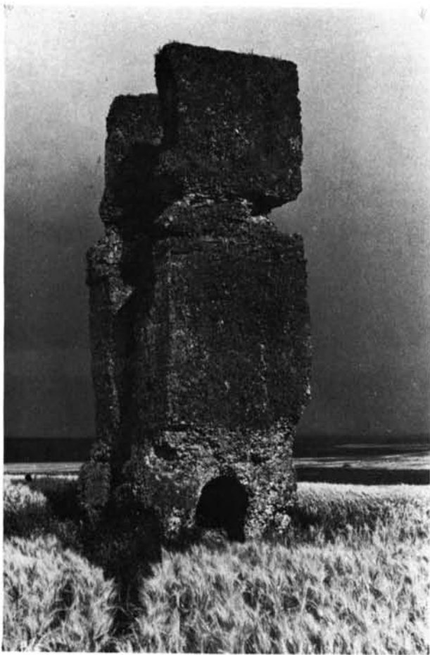
a) Vista Oeste de la Torre.
