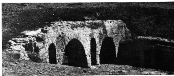
Fig. 7.—Acueducto sobre el arroyo de la Chorrera.
