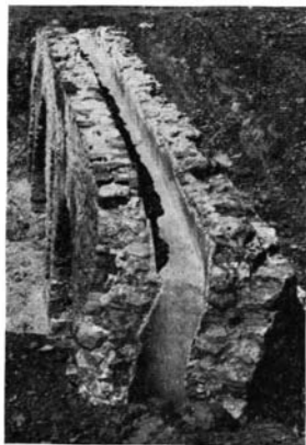
Fig. 11.—Canal y pozo del acueducto sobre el arroyo Chorrera.
