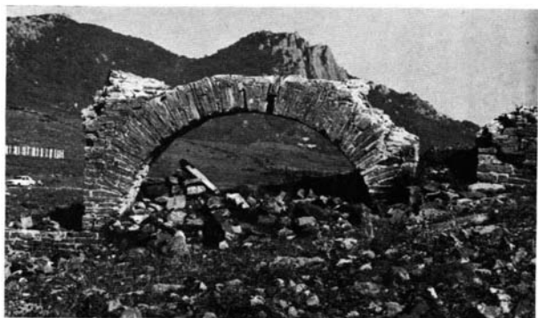
Fig. 2.—Primer arco del acueducto sobre el arroyo Churriana.
