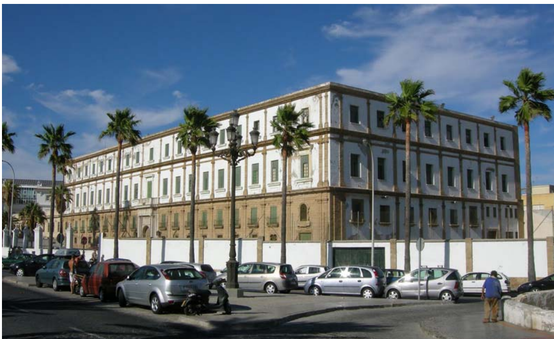
Antiguo Hospicio de la capital gaditana, el noble edificio neoclásico en el que se instaló durante un lustro (1810-1815) la Casa de Moneda de Cádiz, con instrumental y personal de las cecas de las Casas de Madrid y Sevilla
