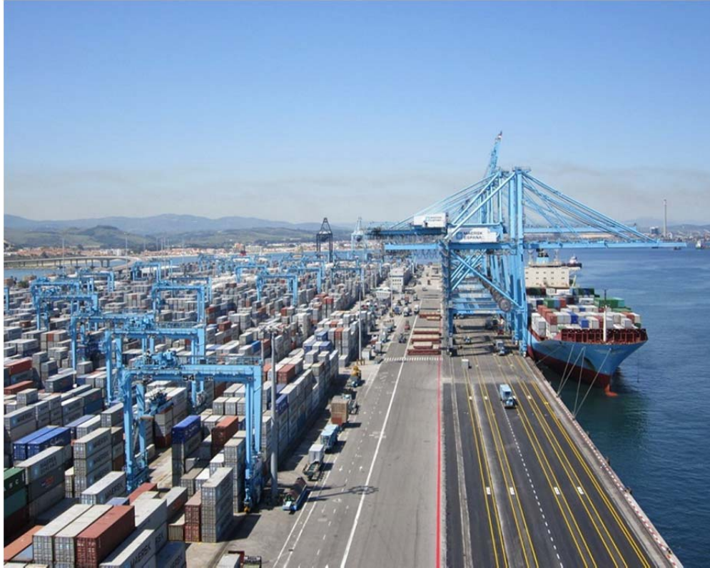
Figura 9. Instalaciones del Puerto de Algeciras
