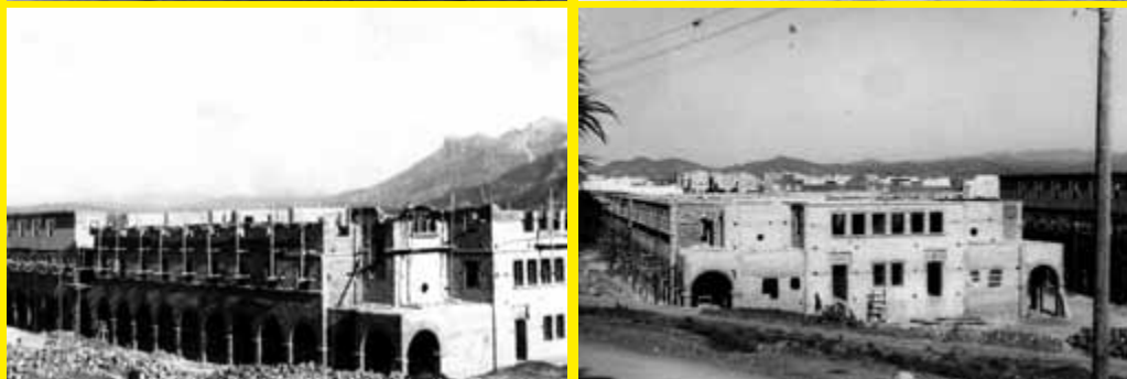
Casas Baratas "General Orgaz" en construcción", 1943.
