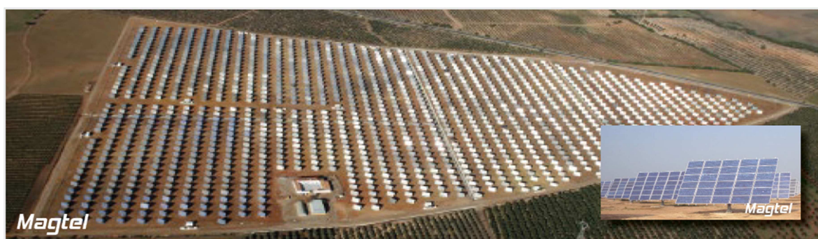
Figura 1-19. Imagen Aérea Instalación Fotovoltaica objeto de Estudio.
