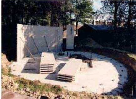
Ilustración 36 Ejemplo de construcción del tanque para el digestor.
