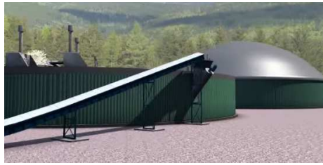
Ilustración 38 Ejemplo de alimentación de un digester anaerobio.
