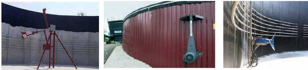
Ilustración 40 Ejemplos de agitación para un digestor anaerobio.
