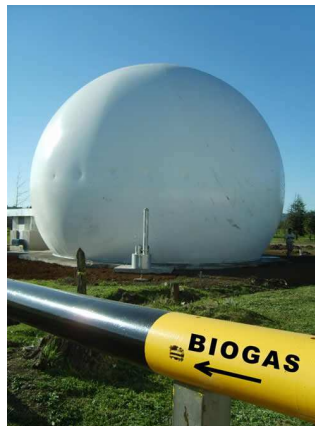
Ilustración 26 Ejemplo de gasómetro a baja presión.
