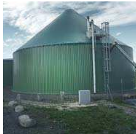
Ilustración 24 Ejemplos de almacenamiento del digestato generado.
