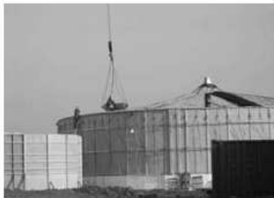
Ilustración 37 Ejemplos de cubiertas de un digestor anaerobio.
