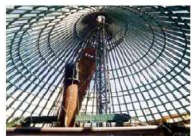
Ilustración 37 Ejemplos de cubiertas de un digestor anaerobio.
