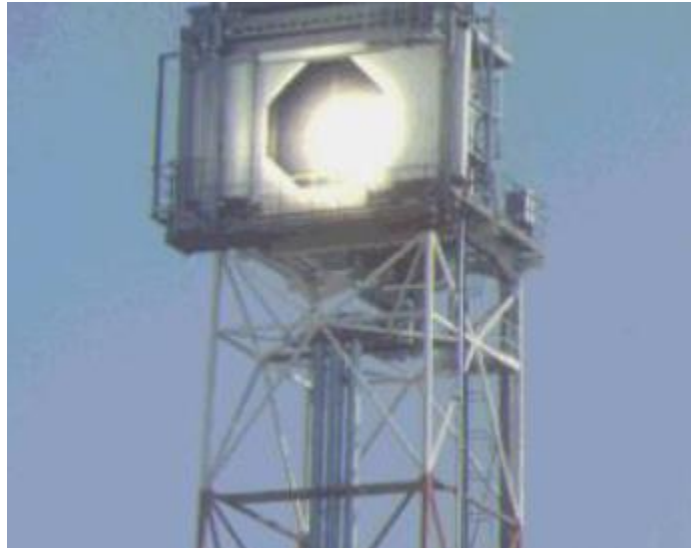
Figura 16. Pérdidas por desbordamiento en torre
