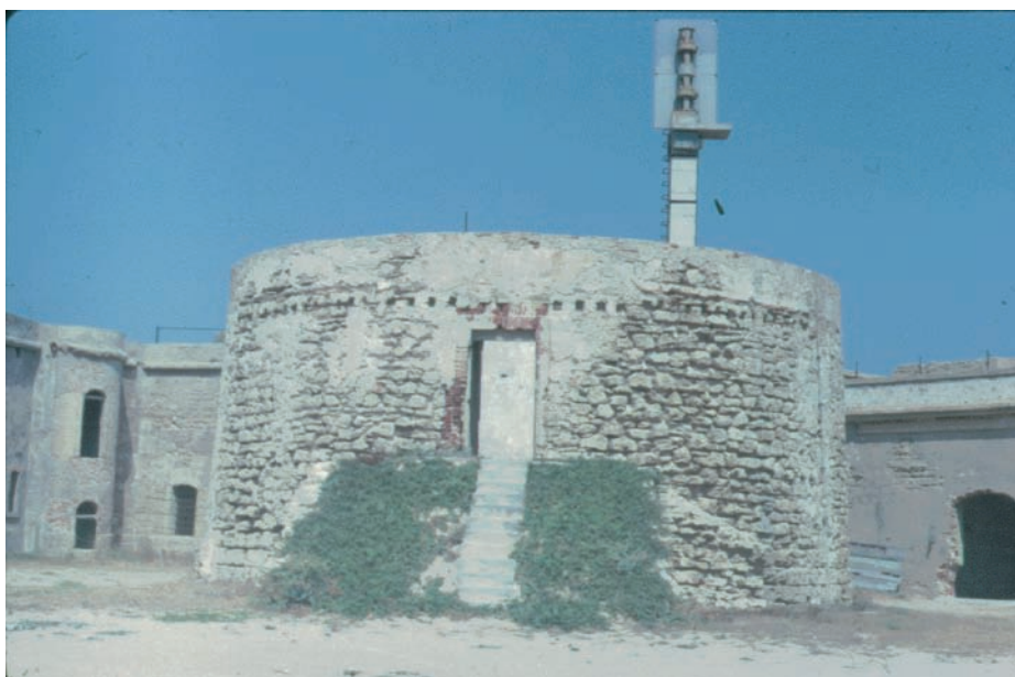
Imagen 3a y 3b. Restos del faro primitivo de Cádiz.
