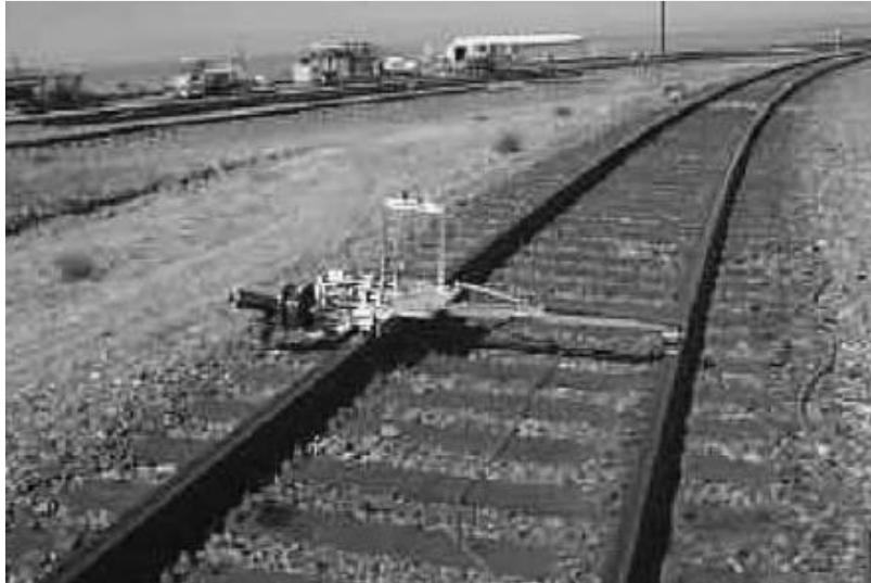
Figura 4. Máquina para montar la fibra óptica al carril.
