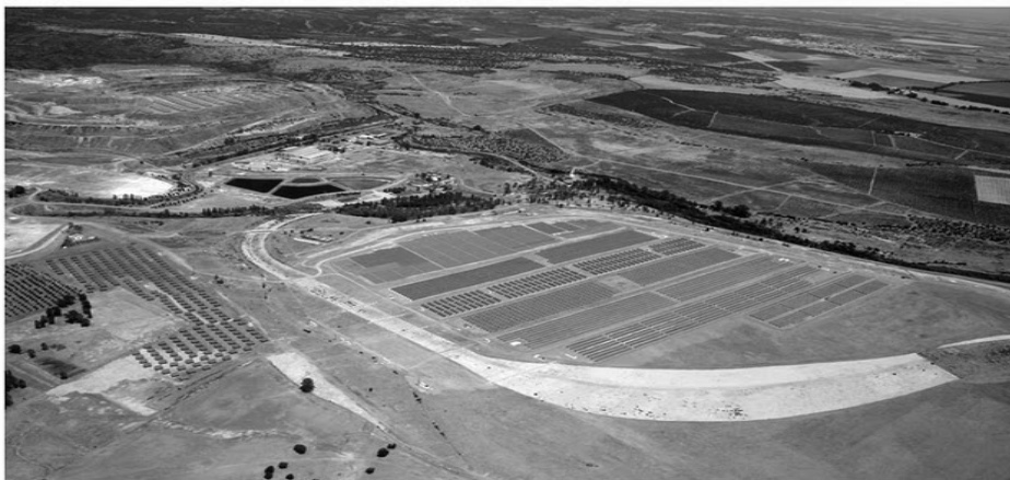
Imagen 2: Planta fotovoltaica en Aznalcóllar.
