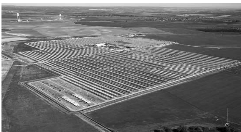
Imagen 4: Planta Solnova 1 en Sanlúcar la Mayor. Al fondo, las torres de PS10 y PS 20.
