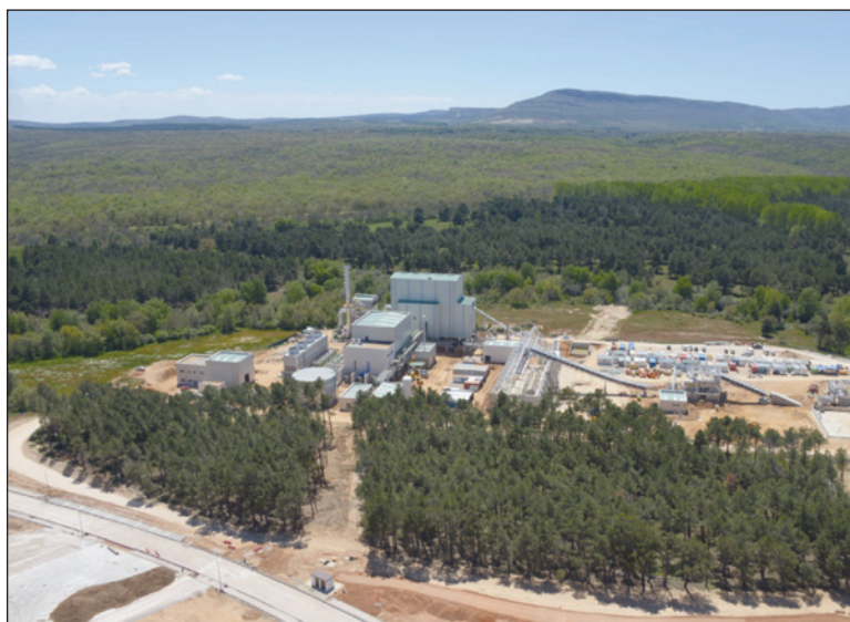
Figura 5 PLANTA DE BIOMASA EN LA CIUDAD DEL MEDIO AMBIENTE. GARRAY (SORIA)
