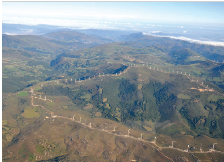
Figura 2 PARQUE EÓLICO EN LAS ALINEACIONES DE LA CORDILLERA CANTÁBRICA, EN EL LÍMITE ENTRE BURGOS Y CANTABRIA
