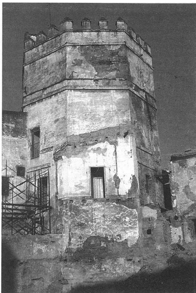
LAM. I. Vista de la Torre de la Plata al comienzo de los trabajos de restauración.
