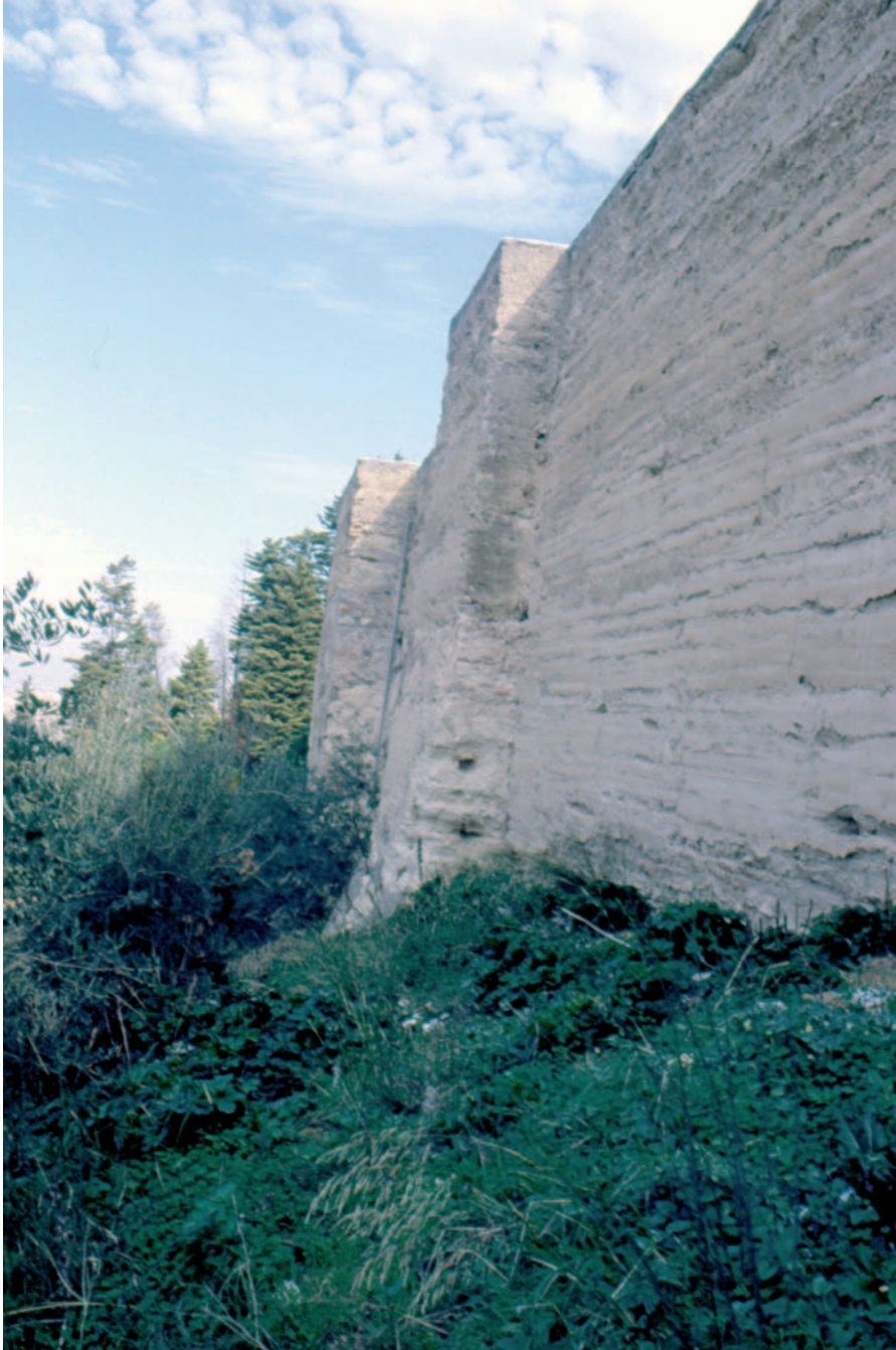
Lámina VI. Detalle del tapial del castillo de Aznalfarache. M. Valor Piechotta.
