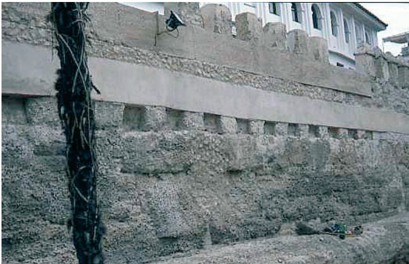
Lámina II. Tabiya . Lienzo de Yahwar o Muro del Agua. Foto M. Valor Piechotta.
