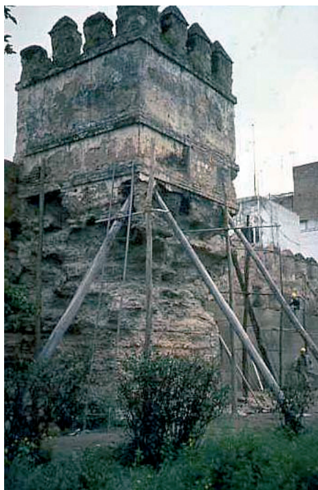
Lámina III. Torre con listeles o verdugadas de ladrillo. Gerencia Municipal de Urbanismo del Ayuntamiento de Sevilla.
