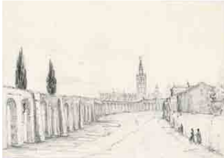
[Il. 55] Sevilla. Caños de Carmona
