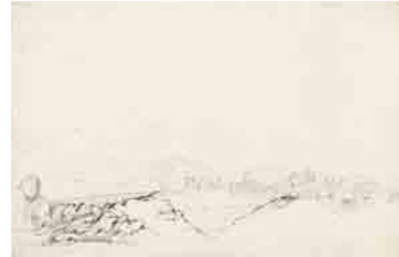
[Il. 80] Plasencia (Cáceres). Vista desde la distancia
