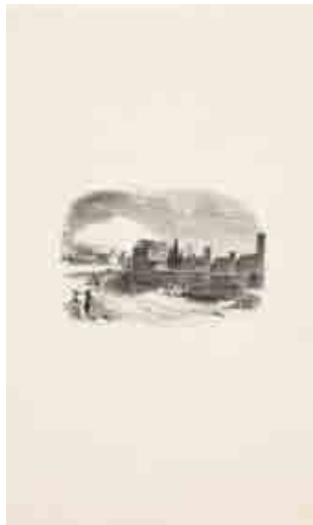
[IL. 22] Sevilla. Murallas junto al Convento de Capuchinos
