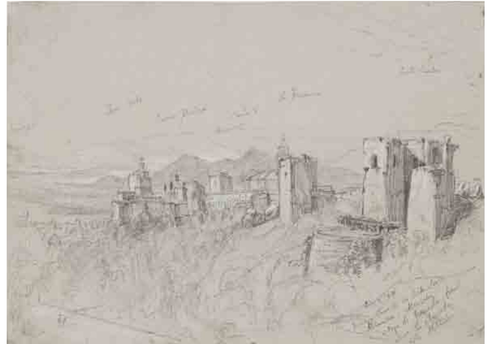
[IL. 71] Granada. Alhambra. Vista general
