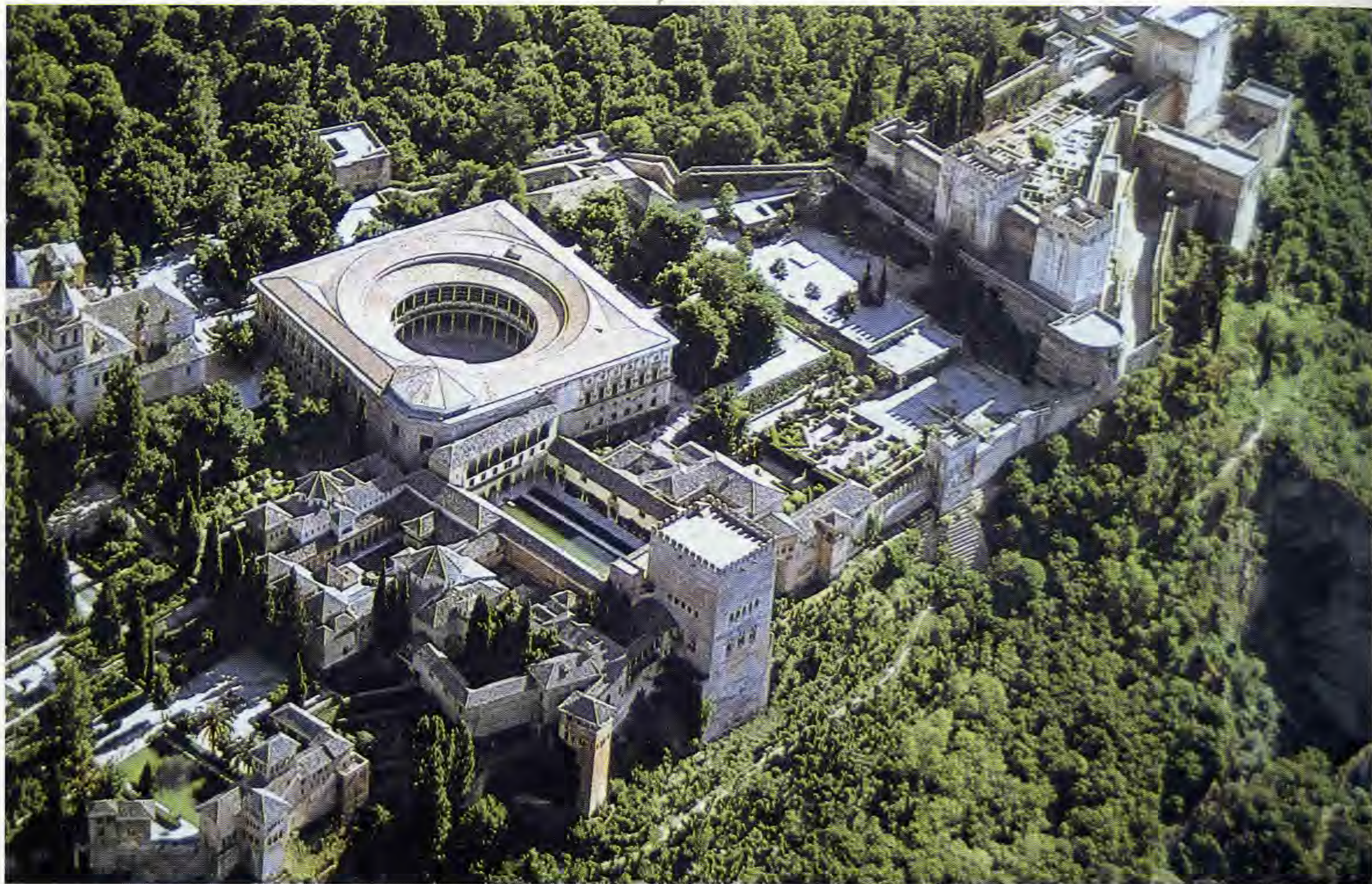
2. Fotografía aérea de la parte oeste de la ciudadela de la Alhambra dibujada en el plano grande. (Procedencia: Incafo-J. y J. Blasi)
