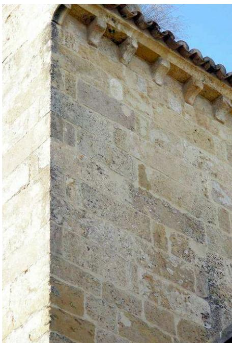
Fig. 7. Aparejo de muro a soga y tizón
